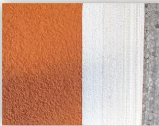
**WDVS-direkt.de® PREMIUM** bietet durch den zementfreien, hoch flexiblen Systemaufbau eine höhere Schlagfestigkeit.
